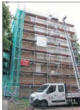
Die Fassade der Sieverstorstraße 43 ist bereits eingerüstet.
